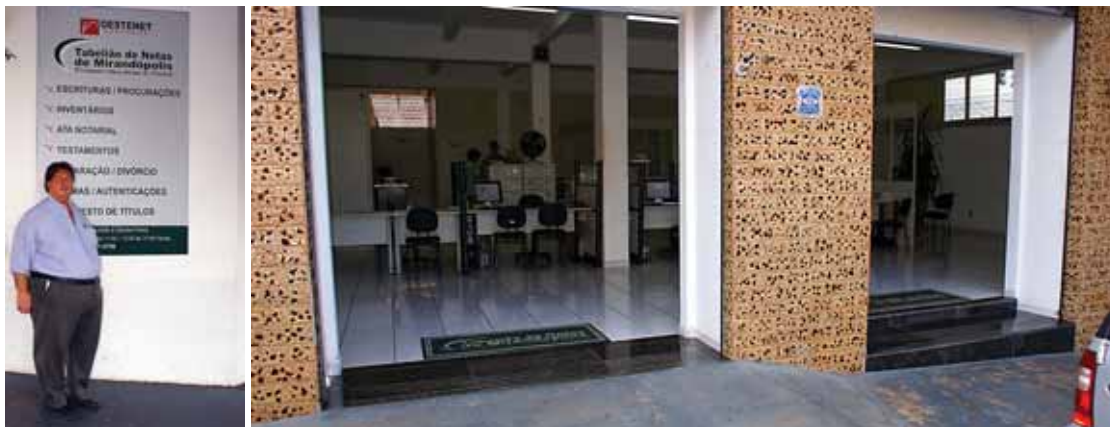
O Tabelião Marco Antonio Greco Bortz, à frente da fachada, em remodelação, do Tabelionato de Notas e Protesto do município de Andradina
