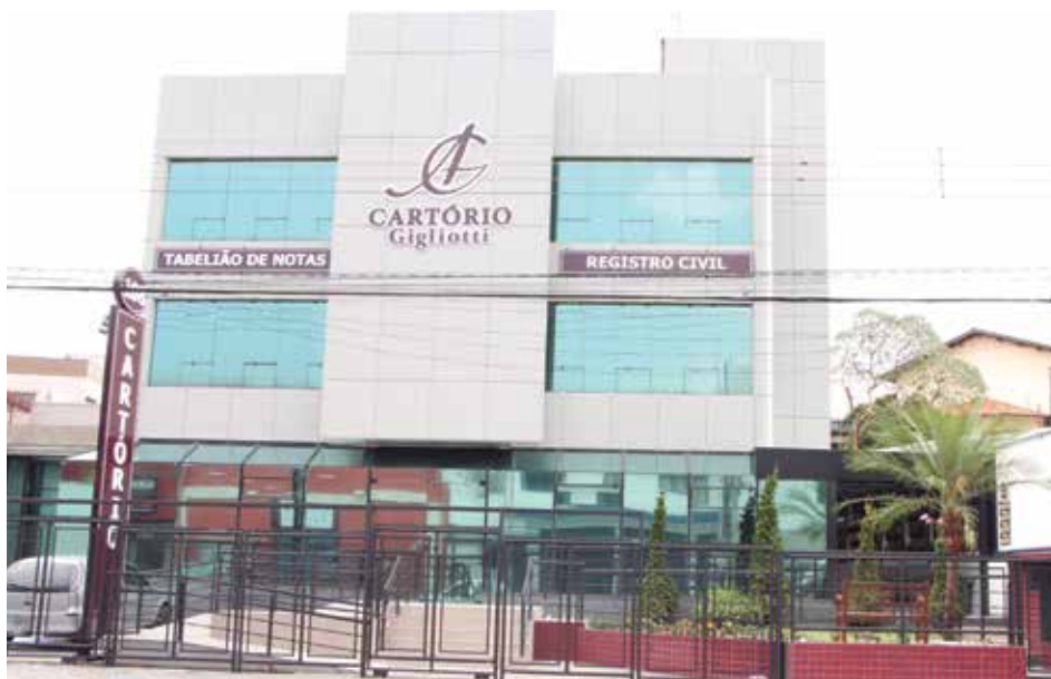
► O Tabelionato de Notas e Registro Civil de São Miguel Paulista teve suas instalações transferidas para um espaço maior com adaptações estruturais voltadas para a acessibilidade de pessoas com deficiência física
