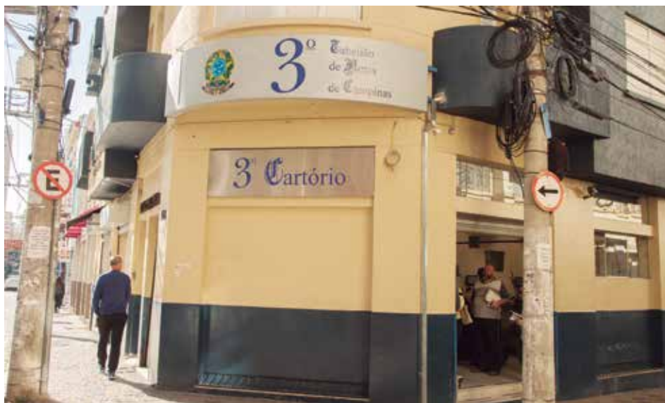
► Melhorias como a transferência das instalações para um espaço maior (3ª sede) e mudanças estruturais na fachada do prédio foram realizadas
