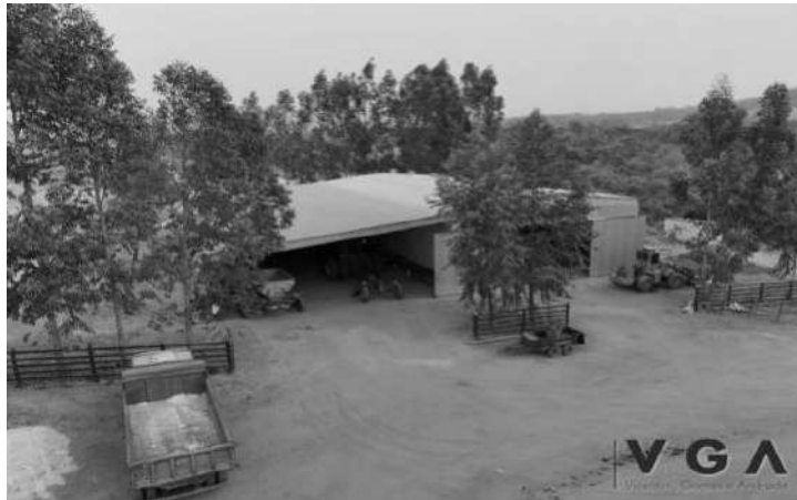
Galpão para armazenamento de insumos e maquinário
