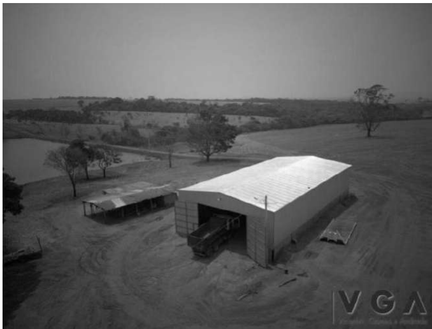
Galpão para maquinários
