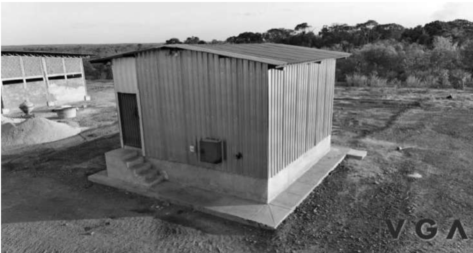
Galpão para armazenamento de combustível.
